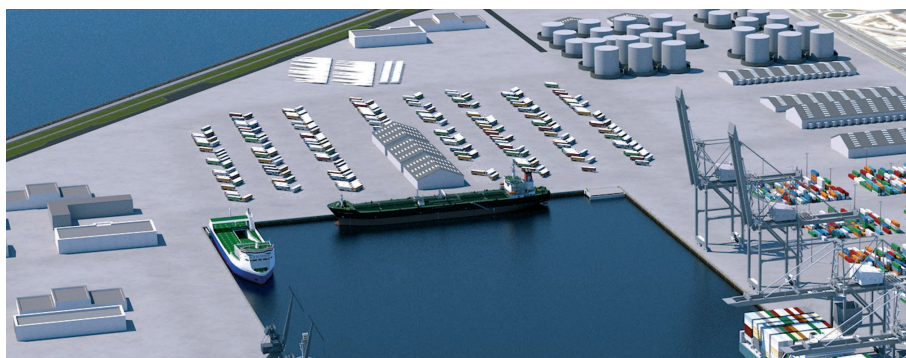
Figur 9 Eksempel på mulig indretning af Ro-ro terminal med pakhuse og opmarcharealer for trailere. Den 350m lange kaj i bunden af havnebassinet fungerer endvidere som tankskibskaj.
